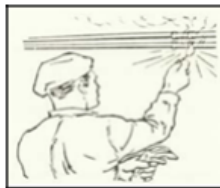
Gambar 12. Tidak menggunakan api untuk cek kebocoran
