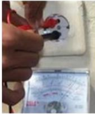
Gambar 11 . Mengukur Tegangan AC PLN
